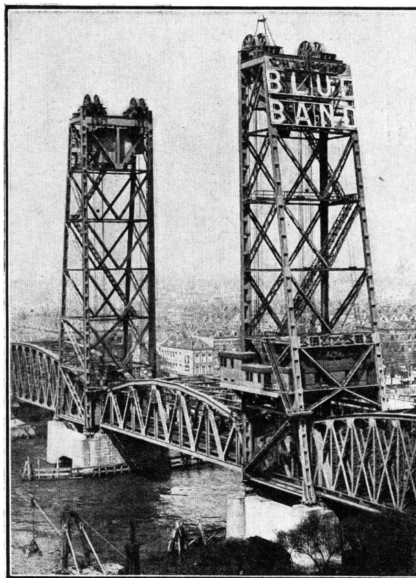
Le Pont-Levant de Rotterdam, vue du Pont, la Travée du milieu abaissée
