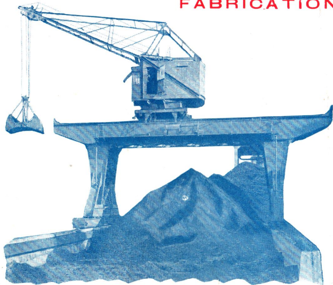
Grue roulante électrique à benne piocheuse sur pont roulant (puissance 3,500 kgs), construite par les Ets Caillard et C ie , Le Havre.
