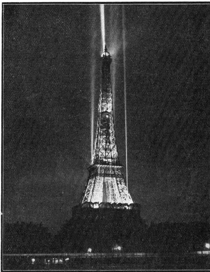
Munie de puissants projecteurs de plusieurs kilomètres de portée, la Tour Eiffel sera visible, la nuit, pendant l'Exposition, à la distance de plus de 100 kilomètres à la ronde. Cette photographie, prise au cours des essais de la nouvelle installation électrique de la Tour, nous a été communiquée par notre confrère Le Dimanche Illustré .
