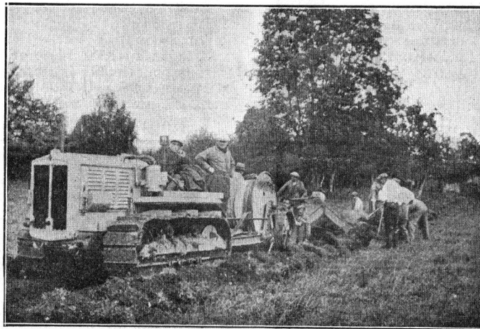
Pose du câble et premier remblayage sous crible.
